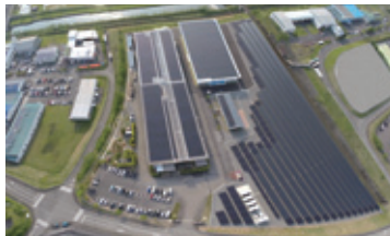
太陽光発電システム
