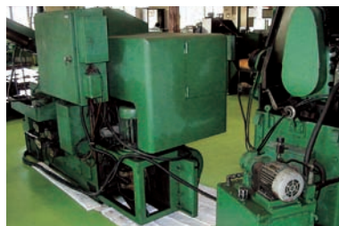
床のエポキシ系塗装とオイル吸収パッド
