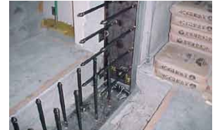
鉄筋挿入しながらのブロック積み
