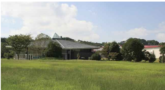
豊かな自然環境と共生する厚生棟と工場棟
