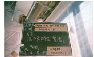
アスベスト除去工事
