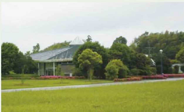
豊かな自然環境と共生する厚生棟
