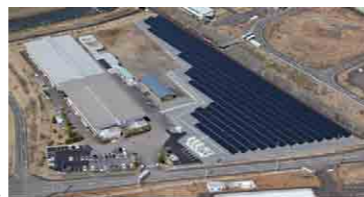
太陽光発電システム
