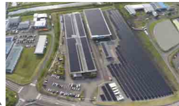
太陽光発電システム
