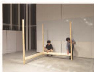
1. 横架材を取り付ける
