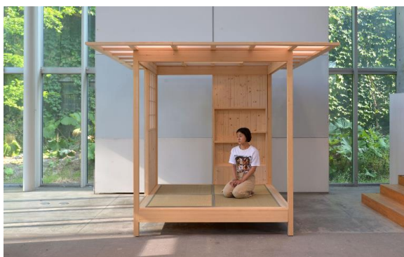
北海道産のトドマツ材を活用した「組立和室」。 北海道大学大学院、海野建設との共同研究。
